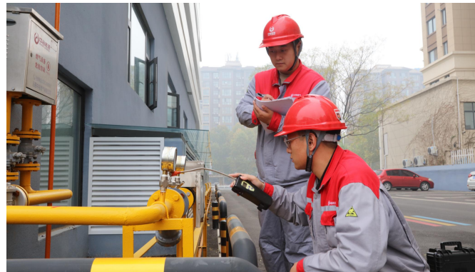
天然气管网检修
