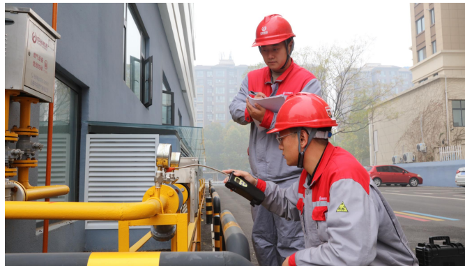
天然气管网检修
