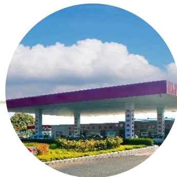
压缩天然气/液化 天然气加气站
