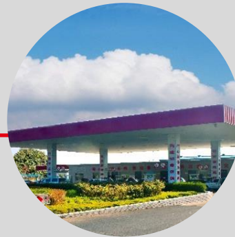
压缩天然气/液化 天然气加气站
